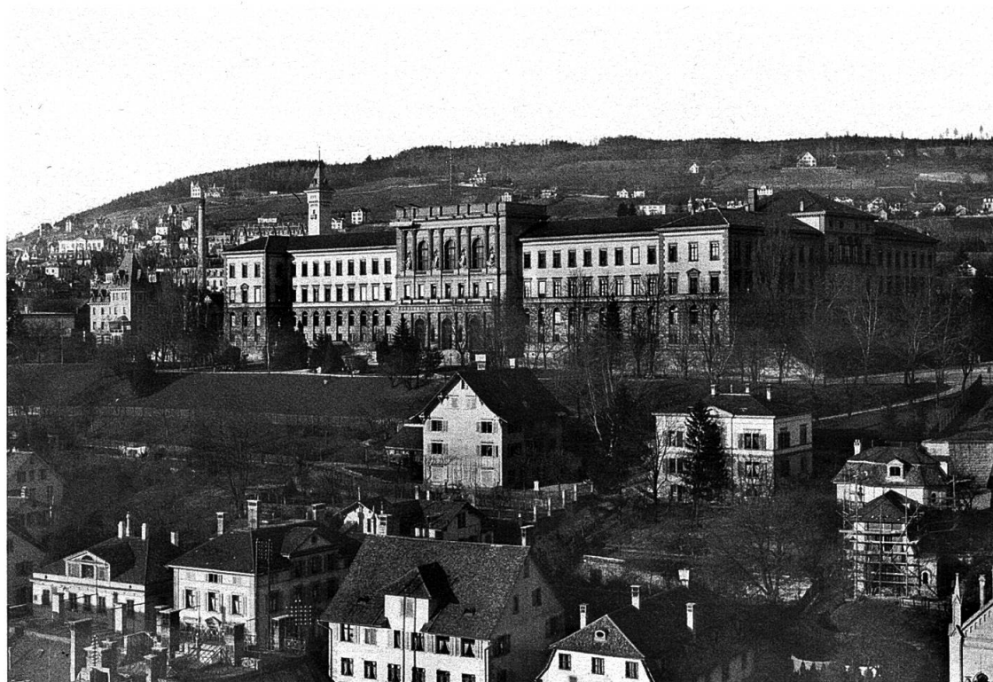
Abb. 41: Zürich, Eidgenössisches Polytechnikum, erbaut 1861–1864 nach Plänen von Gottfried Semper. Aufnahme 1905. (Bern, Eidg. Archiv für Denkmalpflege EAD-WE-2920-B-fp).
