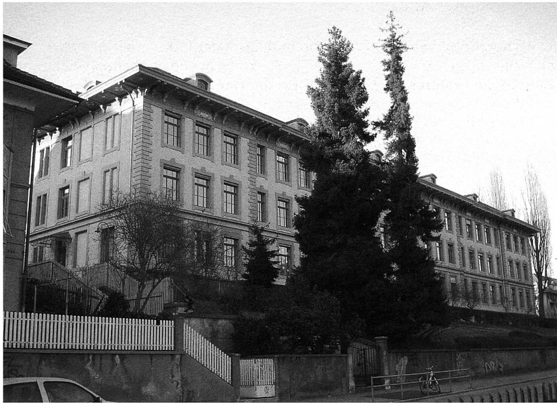
Abb. 26: Bern, Grosses Länggassschulhaus. Ansicht von Süden, Aufnahme 2005. (E.S.).
