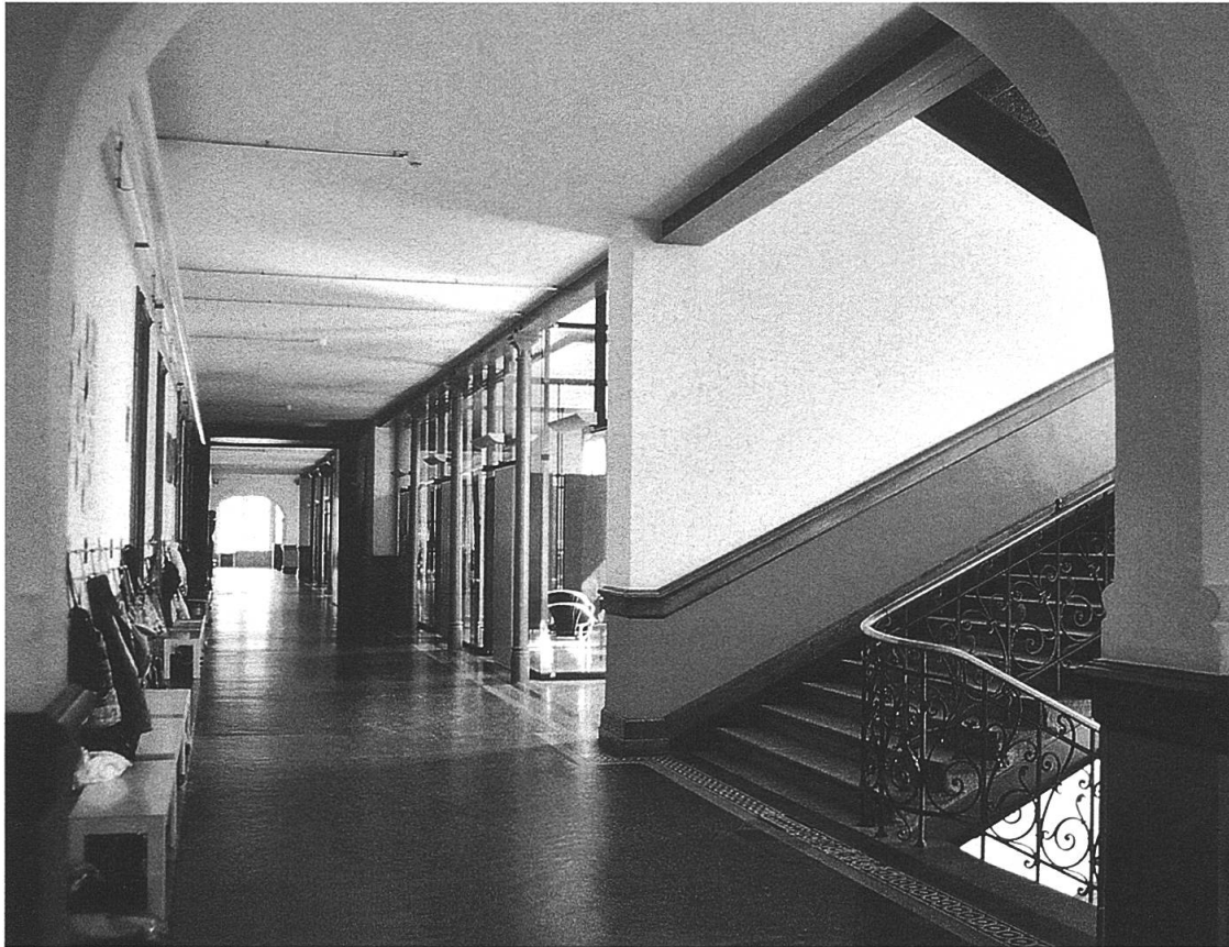
Abb. 29: Bern, Primarschulhaus Spitalacker. Korridor und nördliches Treppenhaus, Aufnahme 2000. In der Bildmitte eine ehemalige Garderobennische. (E.S.).
