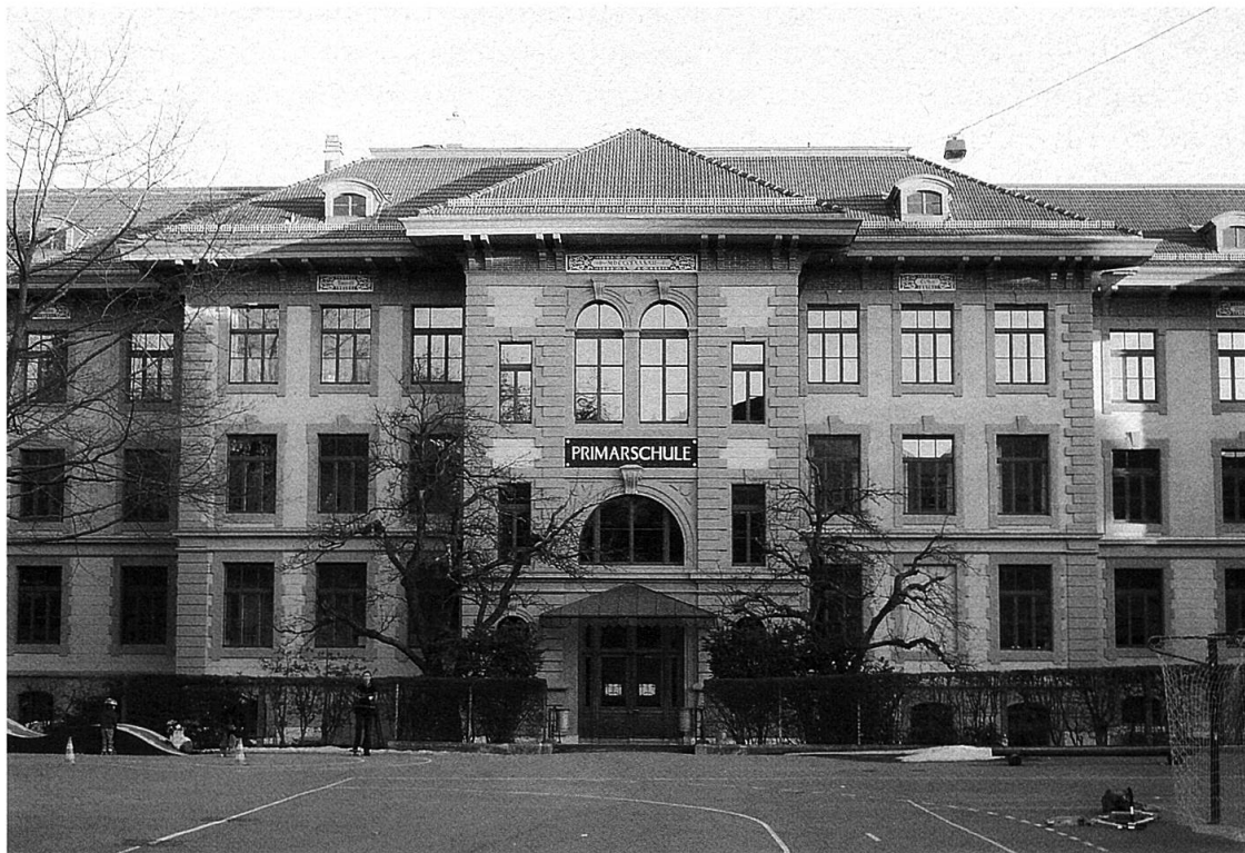
Abb. 27: Bern, Grosses Länggassschulhaus. Nordwestfassade mit dem Treppenhausrisalit, Aufnahme 2005. (E.S.).
