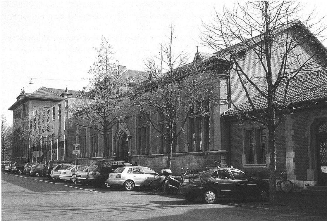
Abb. 61: Turnhalle. Nordfassade an der Kapellenstrasse, Aufnahme 2005. Links im Bild Turnhalle und Aula von 1961/62 anstelle der ehemaligen offenen Spielhalle. (E.S.).
