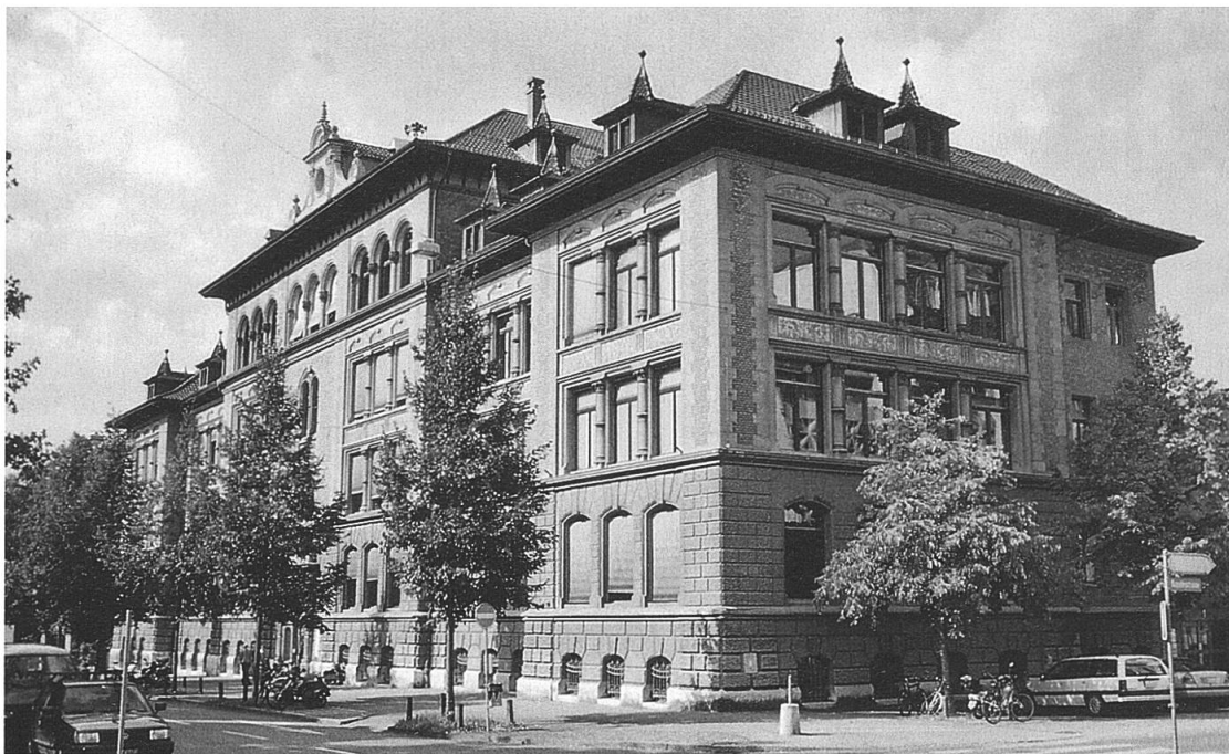
Abb. 53: Hauptfassade. Ansicht von Nordosten, Aufnahme 1999. (E.S.).
