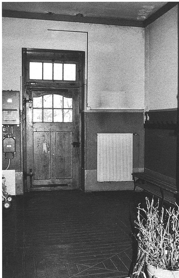
Abb. 31: Courgenay, Schulhaus Courtemautruy. Vorplatz mit Gusszementboden, Aufnahme 2000. (E.S.).
