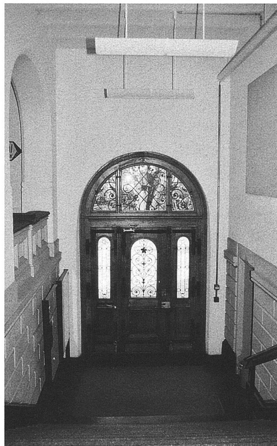
Abb. 67: Haupteingang, Aufnahme 2000. (E.S.).
