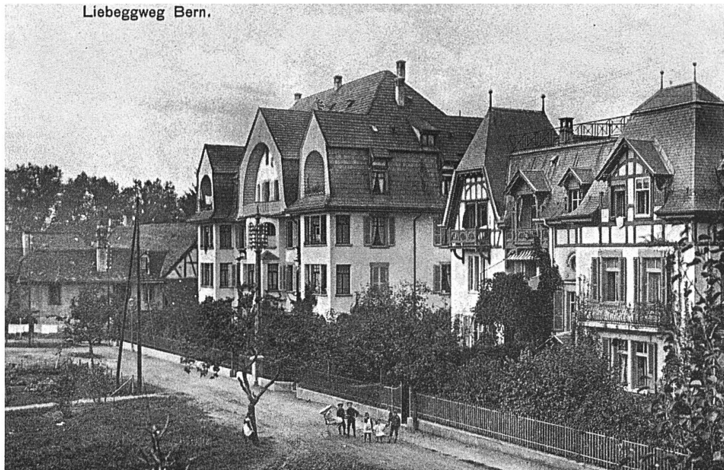
Abb. 85. Liebeggweg 9–13 von 1906/1907 im Obstberg. Aufnahme um 1910.
