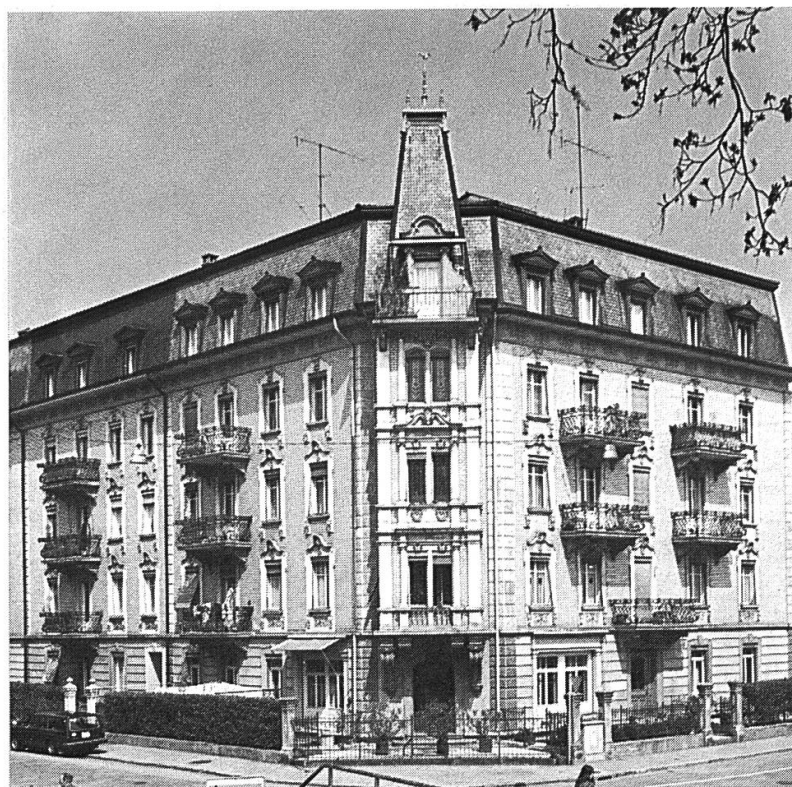
Abb. 75. Muesmattstrasse 34 von 1905 in der Länggasse.
