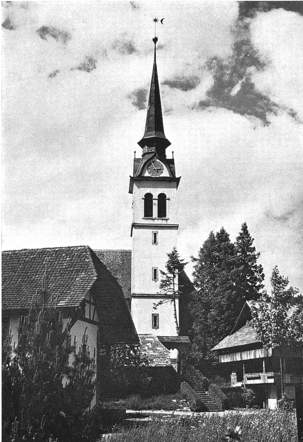
Abbildung 9 Madiswil: Kirchaufgang mit Pfarrscheune, Säulenbrunnen und Speicher. Aufnahme Valentin Binggeli, Langenthal.
