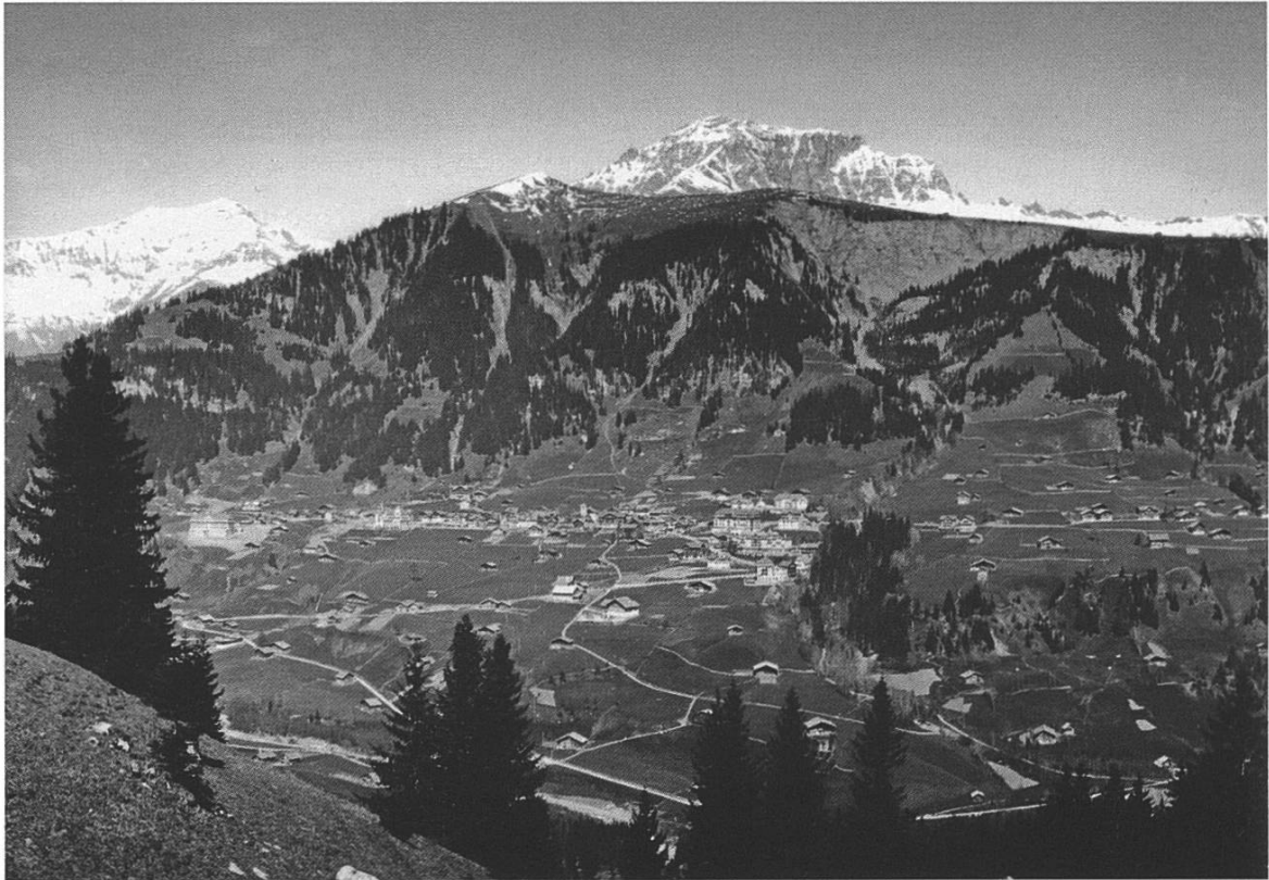
Adelboden 1914, Foto zur Verfügung gestellt von Foto Klopfenstein, Adelboden
