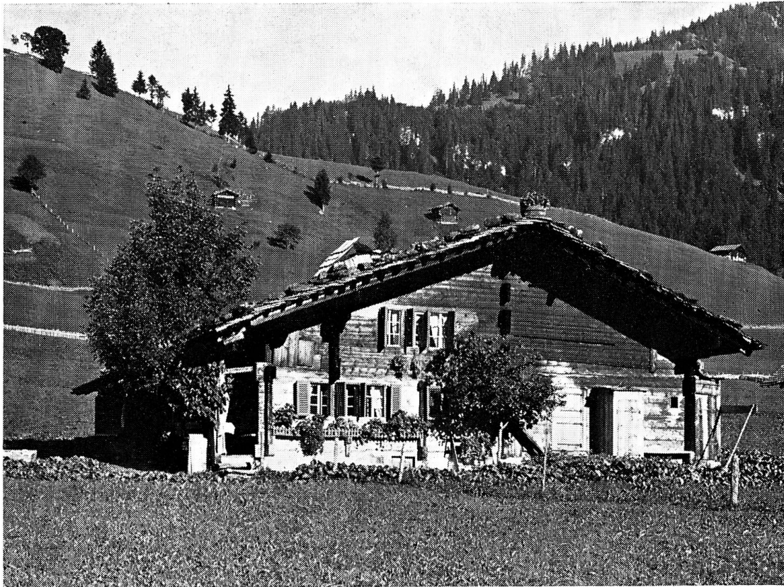
Beim alten Adelbodmer Bauernhaus trennte meist die First die Wohn- von den Oekonomieeilen. Unten rechts: Stall mit (später zugebautem) «Hüsli», darüber die Heubühne. Unten links (Südflügel): «Stuba» mit «Näbetstübli», darüber «Gade», «Cheesgmaach», «oberi Luuba». Hölzerner Rauchfang. Etwas weniger prunkvoll als das Simmentalerhaus, ist dasjenige Adelbodens doch seiner Wandsprüche wegen bekannt. Leider haben Ausbauten und Fenstererweiterungen wertvolle Schnitzereien oft zerstört.
