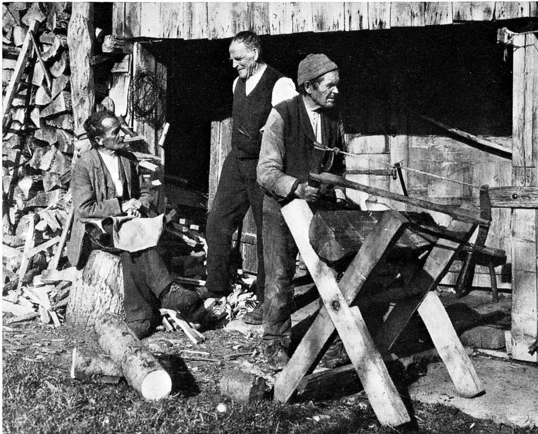
Schittutsch und Sparsaga — altbekannte Geräte zur Verarbeitung der «Speeltene» zu Brennholz (Winter, Vorfrühling).
