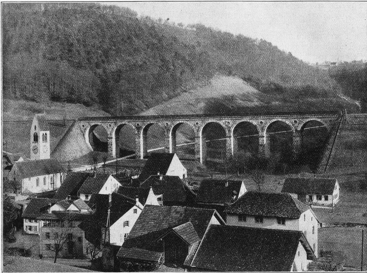
Viadukt bei Gelterkinden.
