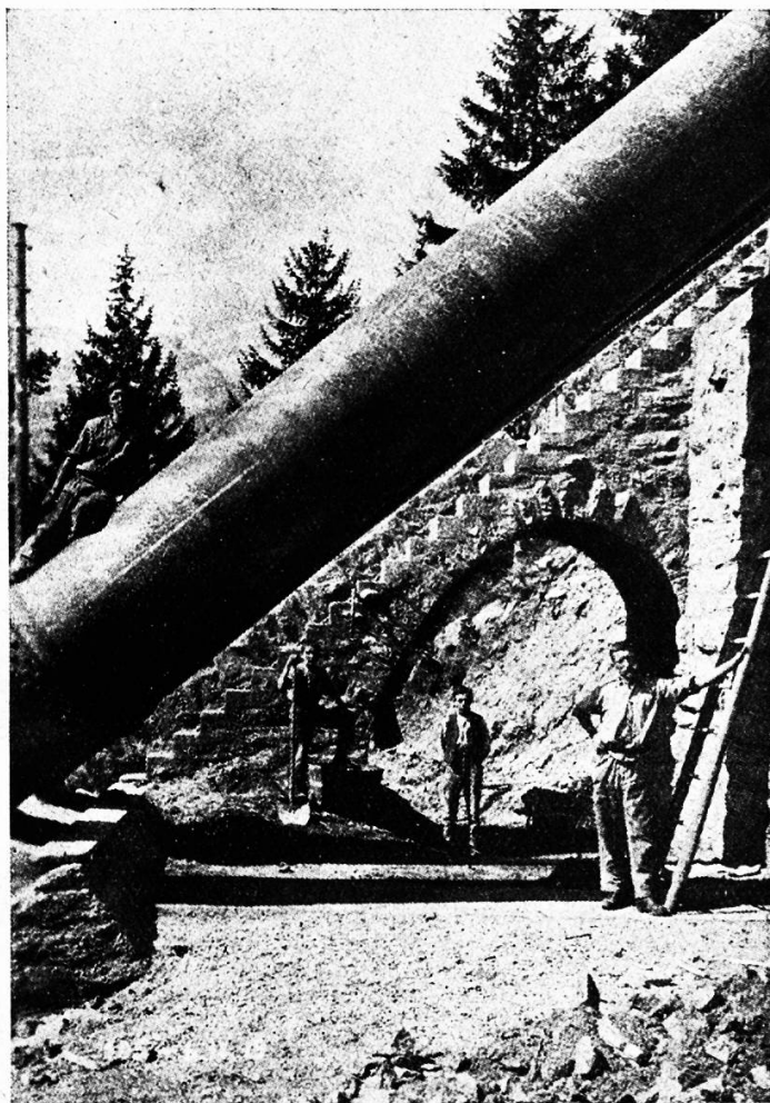
Druckleitung zum Kraftwerk Piotta. Spargewölbe unter der Seilbahn.
