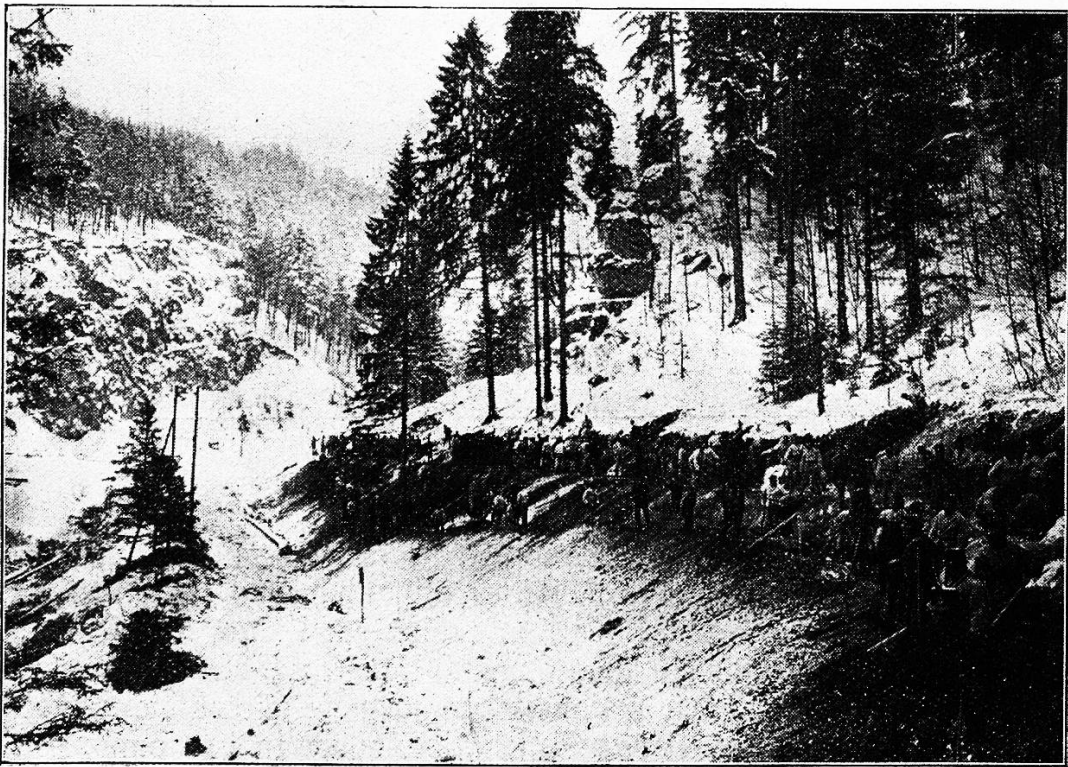
Wegverbesserung in der Schlucht der Pierre-Vertuis.
