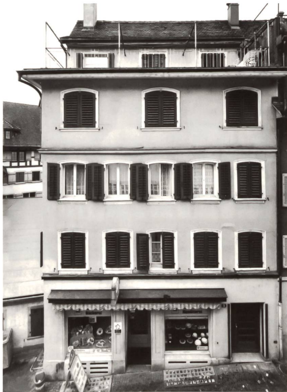
Abb. 6: Haus Kirchenstrasse 3 in Zug. Südfassade. Zustand 2008.
