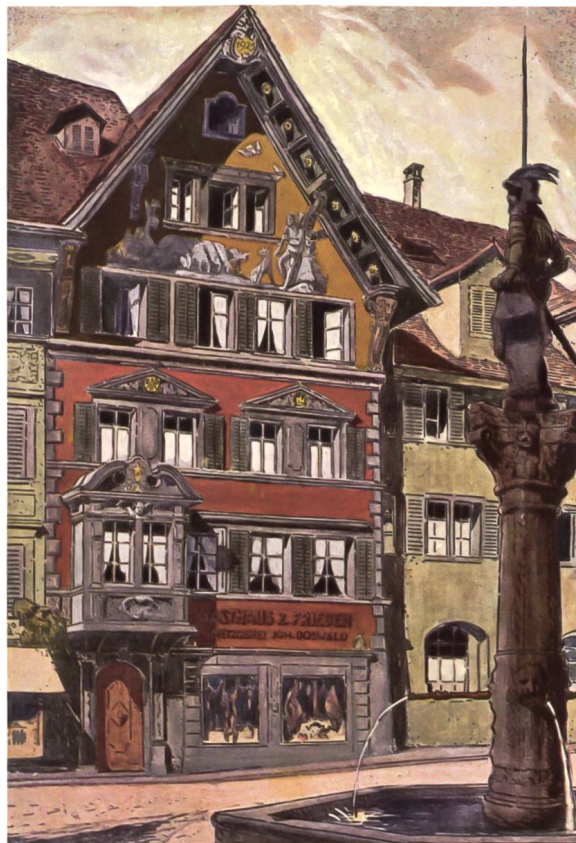
Abb. 1: Haus Kolinplatz 9 «Zum Frieden» in Zug. Süd-fassade. Zustand 1925/1928.
