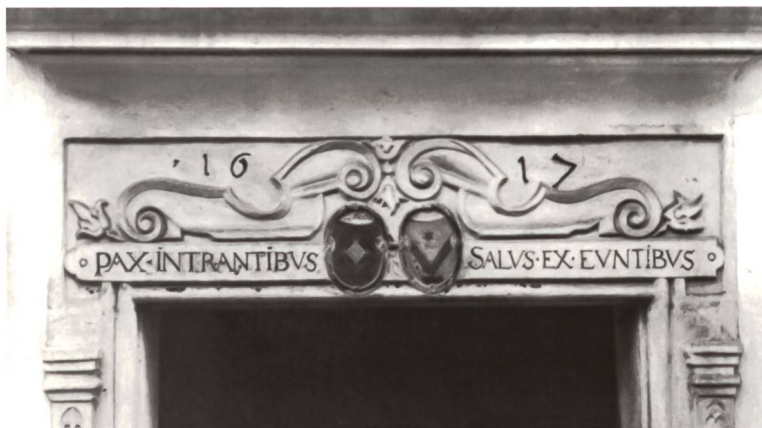
Abb. 8: Haus Kirchenstrasse 3 in Zug. Türgewände, vor der Versetzung im 20. Jahrhundert. Inschriftkartusche und in der Mitte die in den ovalen Scheiben gemalten Wappenschilder der Familien Speck und Landtwing, darüber Rollwerkgiebel und Jahreszahl. Zustand vor 1940.
