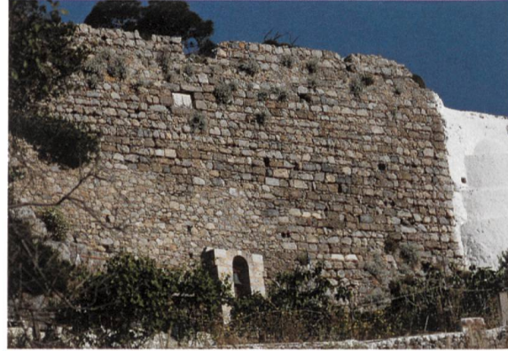
Fig. 5 Pera kastro. Secteur La Geltrù (cl. JBV)
