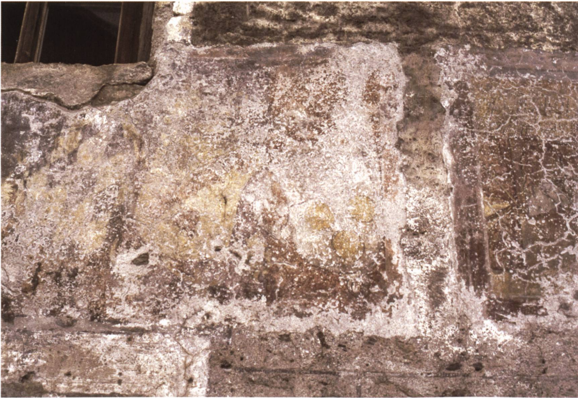
6) Im Wappenfeld 4 ist heraldisch links die untere Hälfte des geteilten Schildes der Herren von Freiberg mit drei goldenen Kugeln zu erkennen. Das derzeit nicht erkennbare heraldisch rechte Wappen dürfte bei einer künftigen Restaurierung wahrscheinlich wieder erkennbar werden Alle Fotos dieses Beitrages von F. H. v. Hye.
