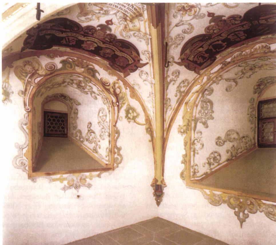
Abb. 4: Nordwestliche Zwickel mit den zwei mal fünf Chorherrenwappen gemäss Abb. 7 und 8.
