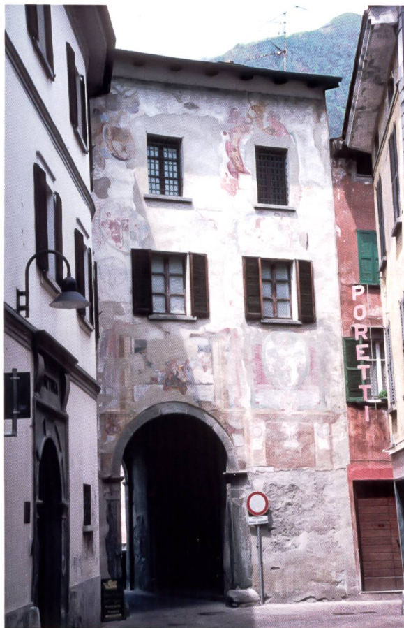
Bild 20: Innenseite der Porta Poschiavina. In diesem Bereich sind zahlreiche Wappen vorhanden, die meisten davon jedoch stark verwittert. Zudem wurden etliche durch Ausbrechen oder Vergrössern von Fenstern arg beschädigt. Links ist das Pretorio von Tirano erkennbar.
