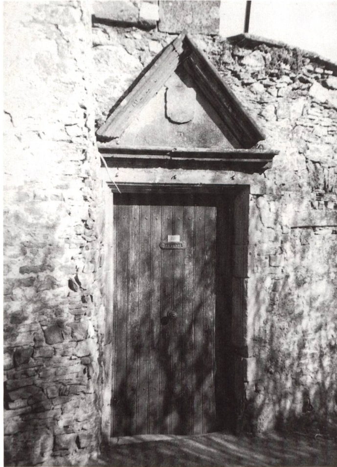
Ill. 9bis Charnay en Beaujolais (Rhône), maison dite de Pravieux : porte sur la rue de Pravieux (l'écu au milieu du fronton devait être aux armes Villeneuve). Cliché M. Franco.
