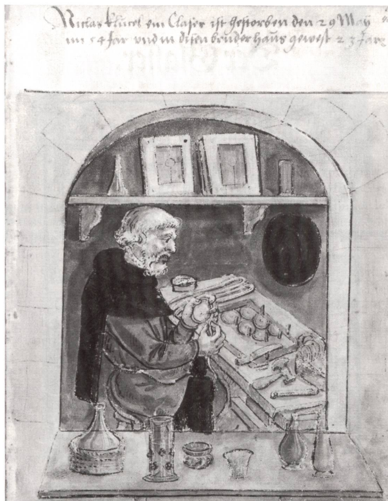
Abb. 1. Der Glaser Niclas Klupch, verstorben am 29. Mai 1554, aus dem Hausbuch der Landauerschen Zwölfbrüderstiftung zu Nürnberg Band I, Blatt 40r. Niclas Klupch schlingt gerade eine Bleirute um eine Butzenscheibe.
