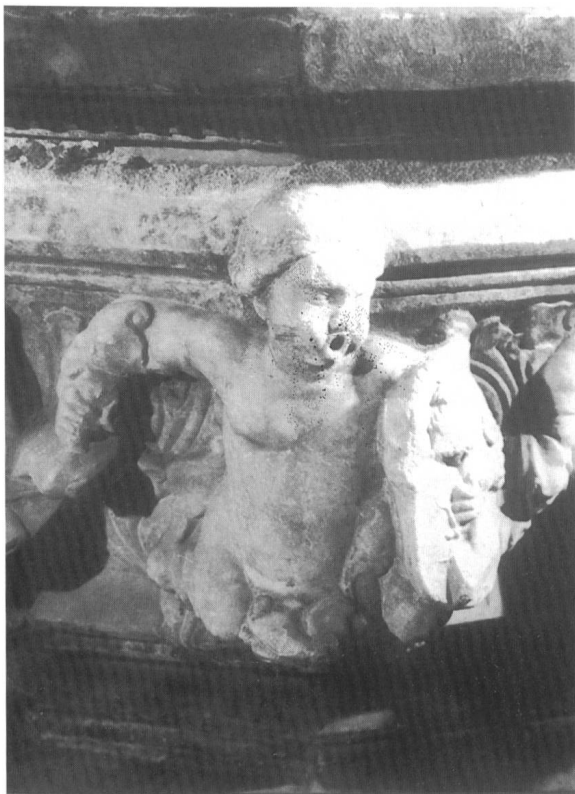
Fig. 19–20 Nella bocche dei putti si vedono chiaramente i fori rimasti dopo l'asportazione delle cannule per l'uscita dell'acqua.
