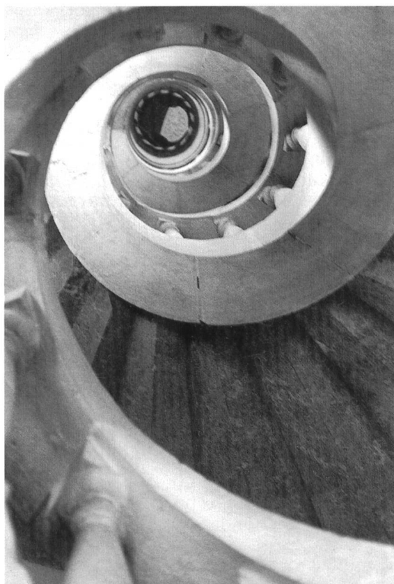
Abb. 1 Das Kunstwerk einer Wendeltreppe ohne Mittelstüd, freitragend sozusagen. Man blickt von unten in das sogenannte Auge.
