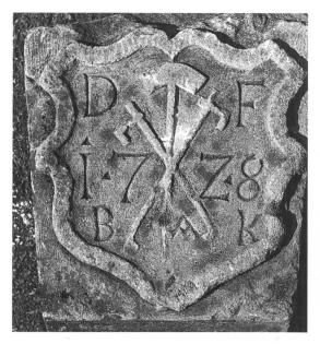
Fig. 21 Emblème de tonnelier, sur clé d'arc déposée, 12, rue des Echasses (1728). On reconnaît ici l'outillage «moderne»: maillet en pal (vertical) et daviers en sautoir (croisés). Les initiales D F et B A K n'ont pu être identifiées.
