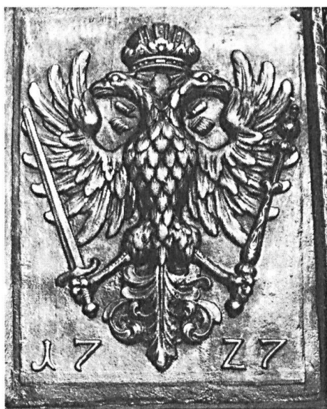
Abb. 32. Planta-Zimmer. Kleiner Ofen aus gusseisernen Platten mit Doppeladler, 1727.
