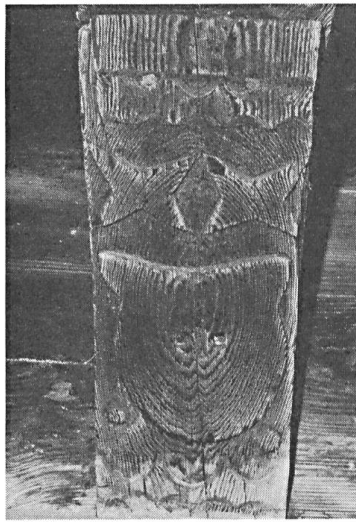
Abb. 57. Gluringen, Konsole 3 mit dem mutmasslichen Hauszeichen der Inderbinen.
