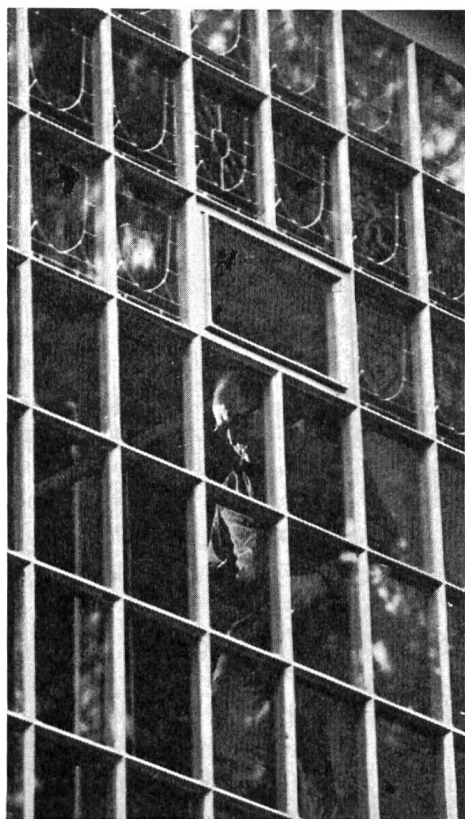
1. Dall'esterno si delinea la struttura geometrica della parte portante della vetrata.
