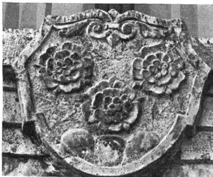
Fig. 2. Ecu aux armes inconnues, 1709 (maison N° 27).
