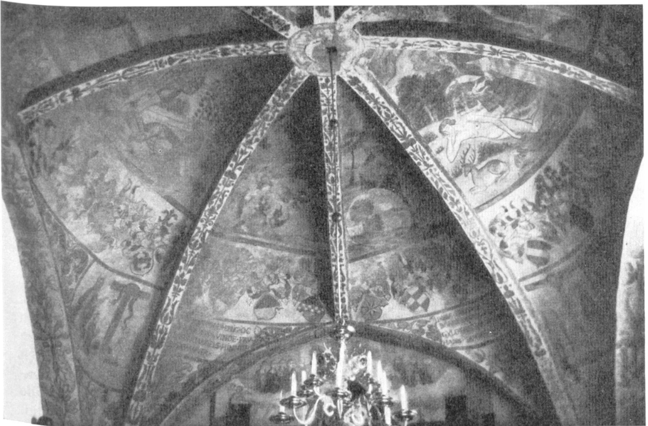
Fig. 1. Deckengewölbe der Adelskirche zu Sønderholm.
