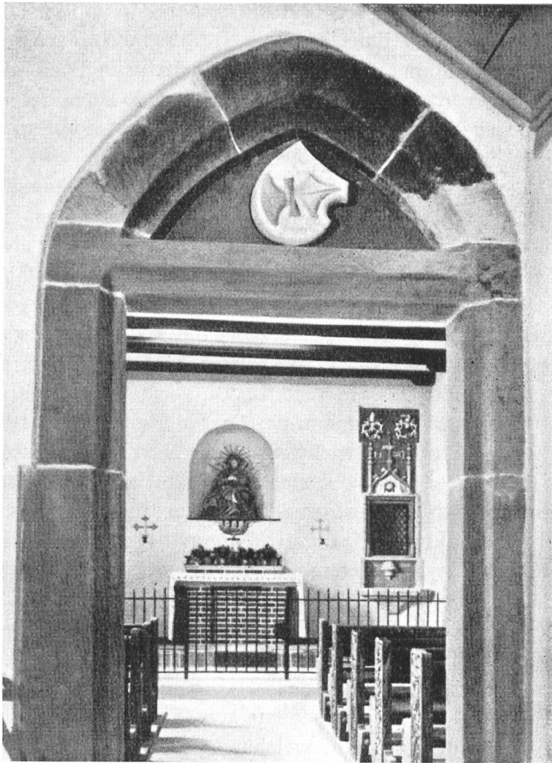
Fig. 94. Blick in die restaurierte Reichensteiner Kapelle.
