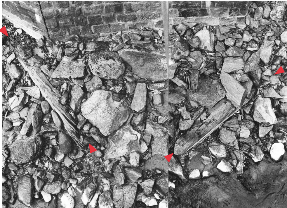
Abb. 51: Scuol. Guarda, un- terhalb Garsun (Stelle 7.9.3). Reste (Balken, Steinschüt- tung) des linksseitigen Pfei- lers der spätmittelalterlich- neuezeitlichen, hölzernen Innbrücke. Blick von oben.
