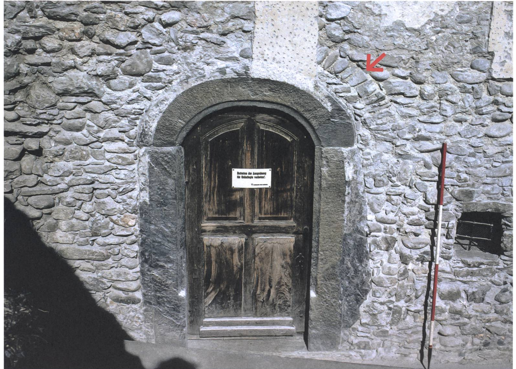
Abb. 141: Domat/Ems, Sogn Pieder. Anlage 2a. Kirche. Entlastungsbogen (Pfeil) des karolingerzeitlichen Eingangs in der Südmauer. Blick nach Norden.
