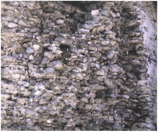
Der Einsturz der Nordostecke im Jahr 1976 ermöglichte einen Blick in den Mauerkern der Apsis **Abb. 136**; **Abb. 137**. An der Stirnseite der Ost- und Nordmauer ist die Schichtung noch gut zu erkennen. Im dazwischenliegenden Teil hingegen sind Bruch- und Bollensteine unterschiedlicher Grösse ohne erkennbare Ordnung und mit wenig Setzmörtel eingefüllt. Als Folge der fehlenden Verdichtung sind überall auch Hohlräume vorhanden.
