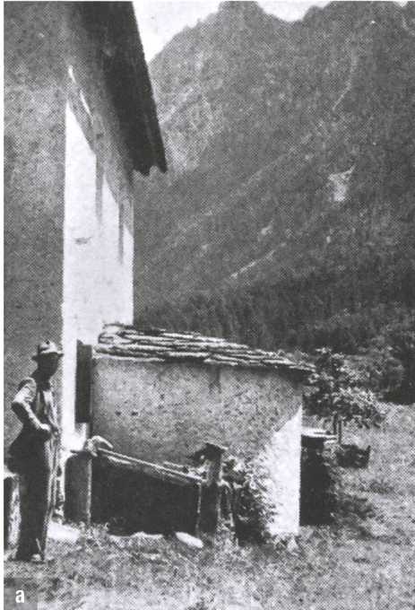
Abb. 167: a Bregaglia, Stampa, Coltura. Apsisförmiger Backofen am Wohnhaus. b Scuol. Der Backofen ist an der Aussenseite der Küche angebaut, er wird durch Konsolbalken gestützt.
