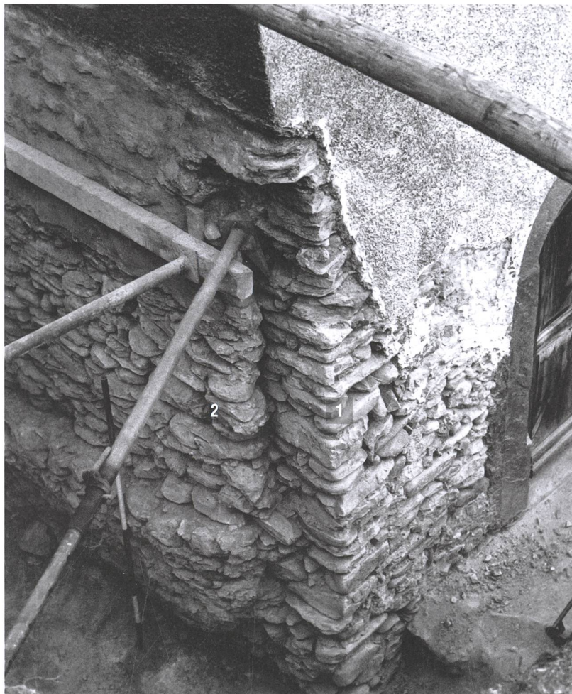
Abb. 27: Domat/Ems, Sogn Pieder. Beim Bau der karolingerzeitlichen Kirche wurde von Anlage 1 ein Teil der Westmauer übernommen. Erhalten blieb die Südwestecke 1. Die anschliessende Partie der Westmauer musste wegen Feuchtigkeitsschäden immer wieder erneuert werden. Die vorspringende Mauer 2 samt Fundament ist im Spätmittelalter (Anlage 3) errichtet worden. Blick nach Nordosten.
