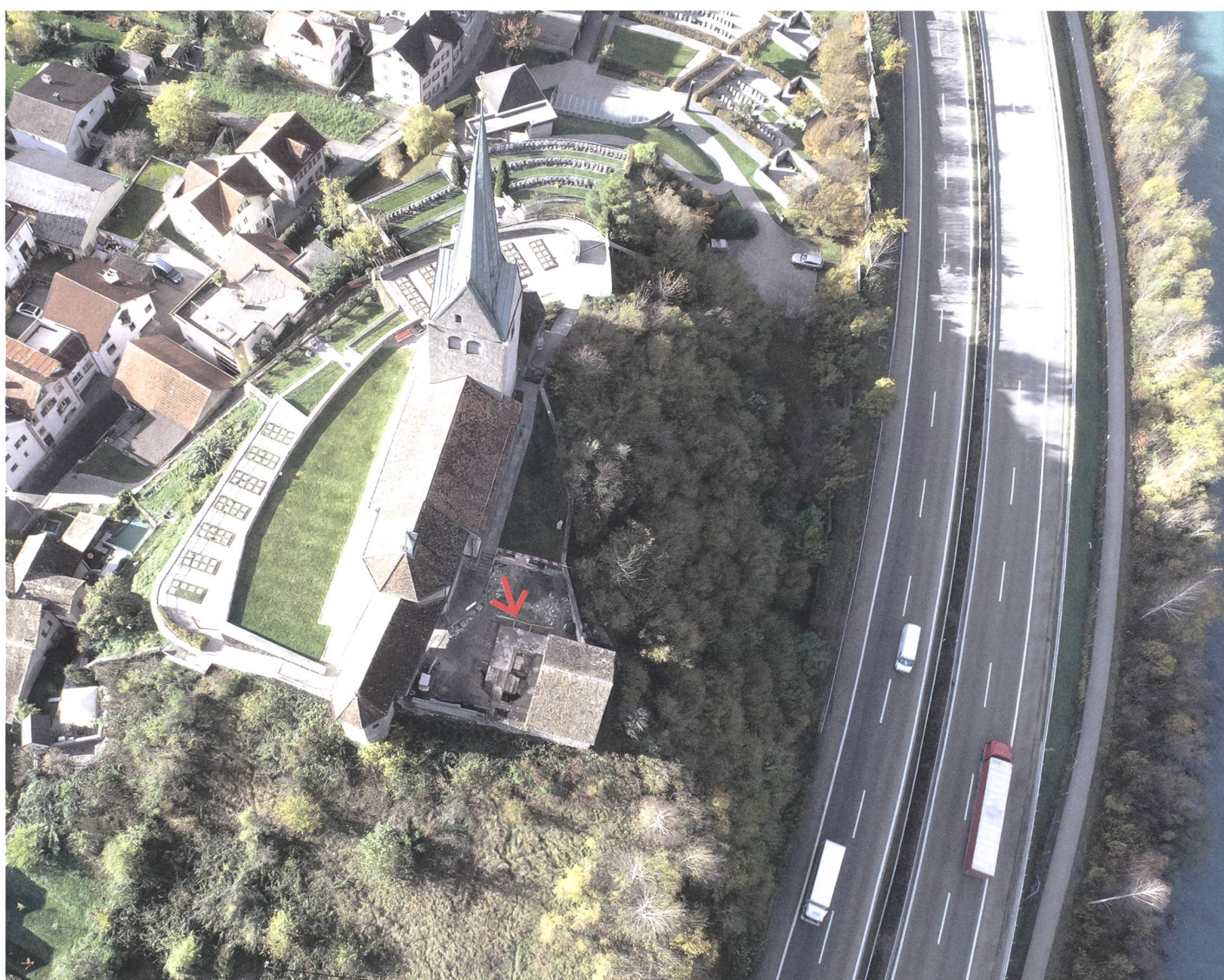
Abb. 11: Domat/Ems. Sogn Gion Battista. An der Nordostecke des Hügelplateaus sind die Mauerreste des Turmes (Pfeil) sichtbar, die im Jahr 2019 untersucht und dokumentiert wurden. Blick nach Westen.
