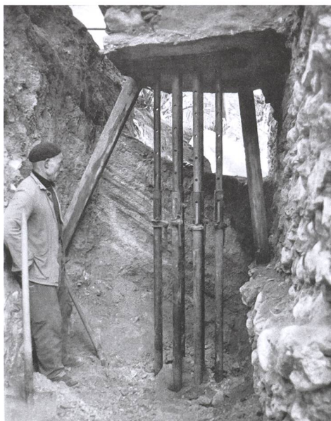
Abb. 16: Domat/Ems, Sogn Pieder. Für den Bau der Stützmauer und der Entwässerung wurde hangseitig vor der Westfassade ein bis zum Fundament reichender Graben ausgehoben. Der Turm musste bis zum Abschluss der Arbeiten mit Bauspiessen gestützt werden. Blick nach Norden.
