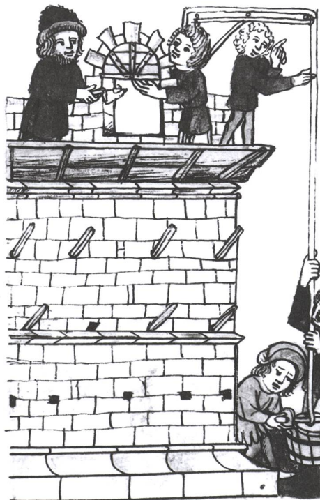
Abb. 139: Mittelalterliche Abbildung eines Auslegergerüsts (15. Jahrhundert).
