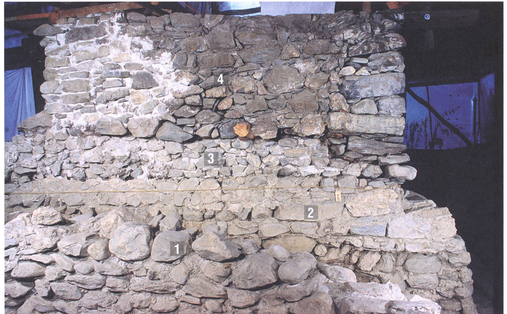
Abb. 450: Tomils, Sogn Murezi. 1 Reste der Südmauer des frühmittelalterlichen Südannexes E, 2 abgebrochene Friedhofsmauer (50), 3 erneuerter Mauerabschnitt (334), 4 neuzeitliche Trockenmauer (335), in Teilbereichen mit modernem Mörtel gesichert. Blick nach Süden.
