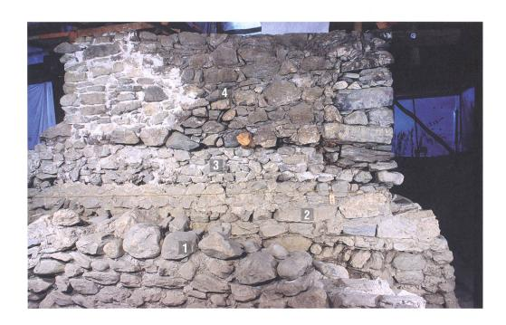
**Abb. 450:** Tomils, Sogn Murezi. **1** Reste der Südmauer des frühmittelalterlichen Südannexes E, **2** abgebrochene Friedhofsmauer (50), **3** erneuerter Mauerabschnitt (334), **4** neuzeitliche Trockenmauer (335), in Teilbereichen mit modernem Mörtel gesichert. Blick nach Süden.
