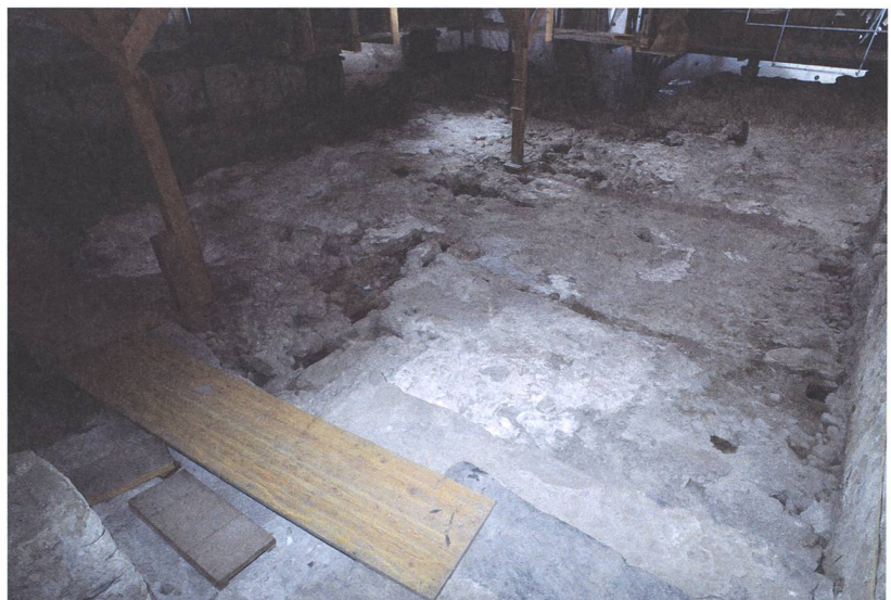
Abb. 437: Tomils, Sogn Murezi. Kalkansammlung auf dem Kirchenboden. Blick nach Südwesten.
