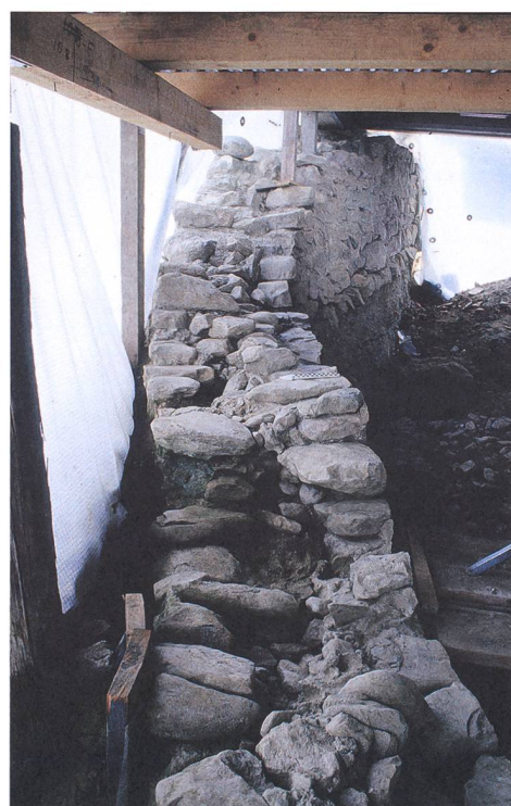
Abb. 412: Tomils, Sogn Murezi. Wie die Abbruchkante zeigt, wurde die Friedhofsmauer (50) als Schalenmauerwerk errichtet. Blick nach Osten.
