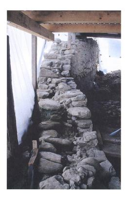
**Abb. 412:** Tomils, Sogn Murezi. Wie die Abbruchkrone zeigt, wurde die Friedhofsmauer (50) als Schalenmauerwerk errichtet. Blick nach Osten.
