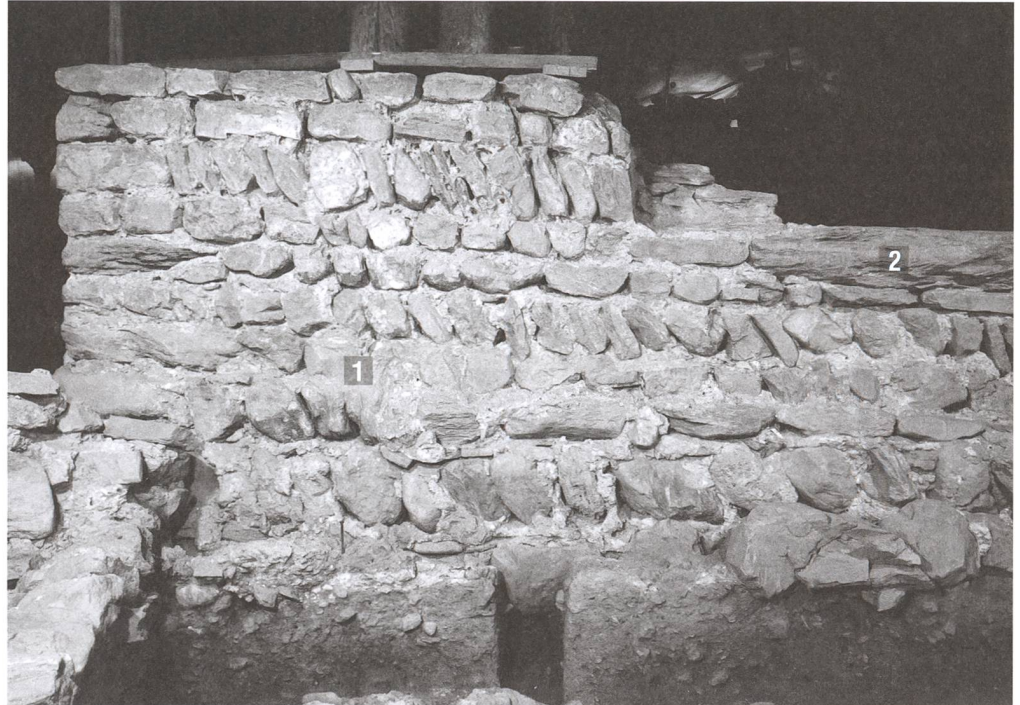
Abb. 399: Tomils, Sogn Murezi. 1 Südfassade (7a) und Süd- westecke (79) der romani- schen Kirche, 2 Schwelle (961) des Kircheneingangs. Blick nach Norden.
