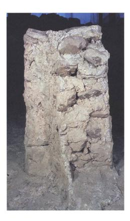
Abb. 328: Tomils, Sogn Murezi. Südannex E. Der Durchgang (1048) in der Binnenmauer (1047). Deutlich ist der Abdruck des Schwellenbrettes und des Türstocks im Mörtel zu erkennen. Blick nach Süden.
