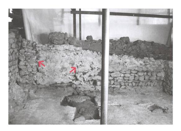
**Abb. 322:** Tomils, Sogn Murezi. Südannex E. Mit dem Mauerwerk der erneuerten Südmauer (1026) wurde gleichzeitig der Durchgang (1031/1033) (Pfeile) verschlossen. Blick nach Süden.
