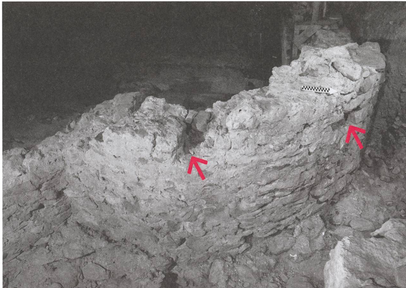
Abb. 203: Tomils, Sogn Murezi. Dreiapsidensaal. Das Mauerwerk der nördlichen Apsis mit erhaltenen Balkenlöchern (968a und 968b, Pfeile) (vgl. Abb. 193 ). Blick nach Westen.
