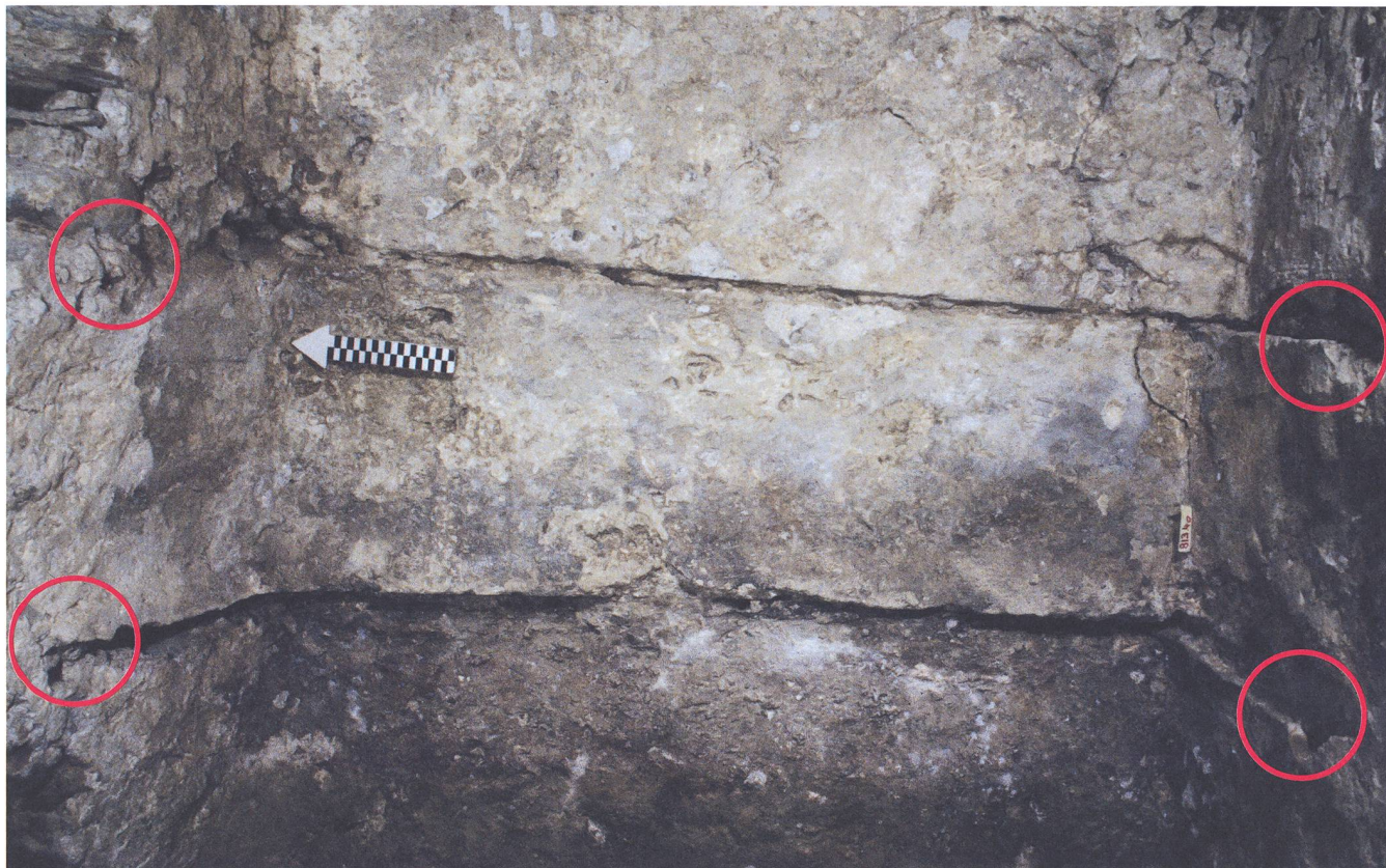
Abb. 111: Tomils, Sogn Murezi. Negative zweier Tablare (968) im südlichen Seitenraum zum Sanktuarium. Sie gehörten einst zu einem Wandregal oder einem Wandkasten. Die Vertiefungen für die Keile oder Unterzugsbalkchen sind mit einem Kreis gekennzeichnet. Blick nach Osten.
