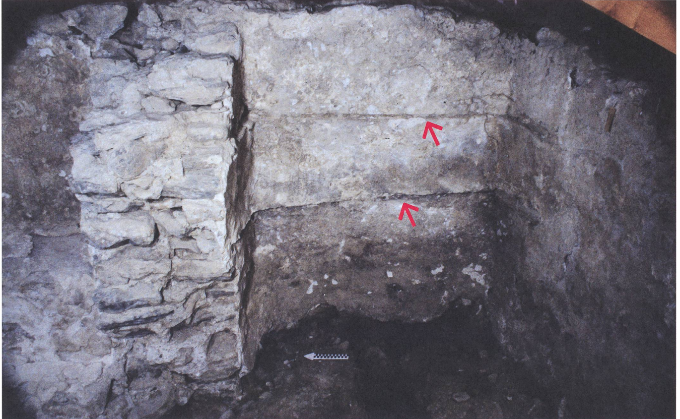
Abb. 85: Tomils, Sogn Murezi. Der südliche Seitenraum besass einen Lehmbofen (hier grösstenteils abgebaut) und ein Wandregal oder einen Wandkasten, von dem die Negative (Pfeile) erhalten sind. Blick nach Osten.
