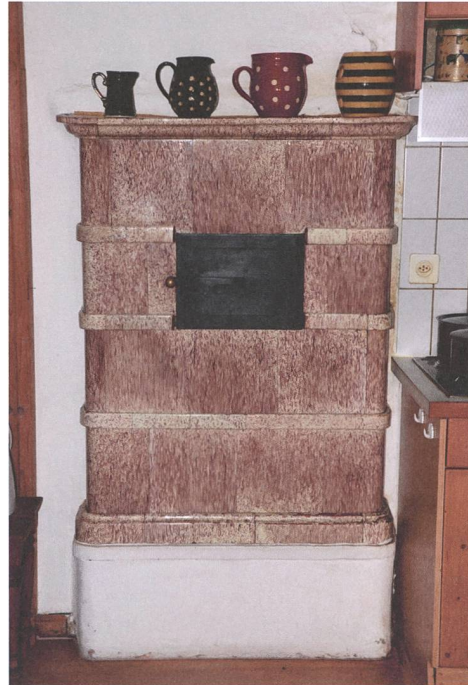
Abb. 256: Jenaz, Hauptstrasse 117. Kachelofen und Kunstwand aus gepressten Kacheln, wohl von Christian Löttscher (1821–1880), nach 1866. Dekor mit Farbkörpern in der Grundengobe.
