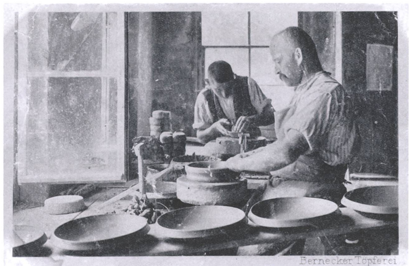
Abb. 303: Hafner von Berneck SG an der Töpferscheibe. Seitlich stehen fertig gedrehte Platten mit scharfkantigem Kragenrand. Undatierte Ansichtskarte, um 1920/30.
