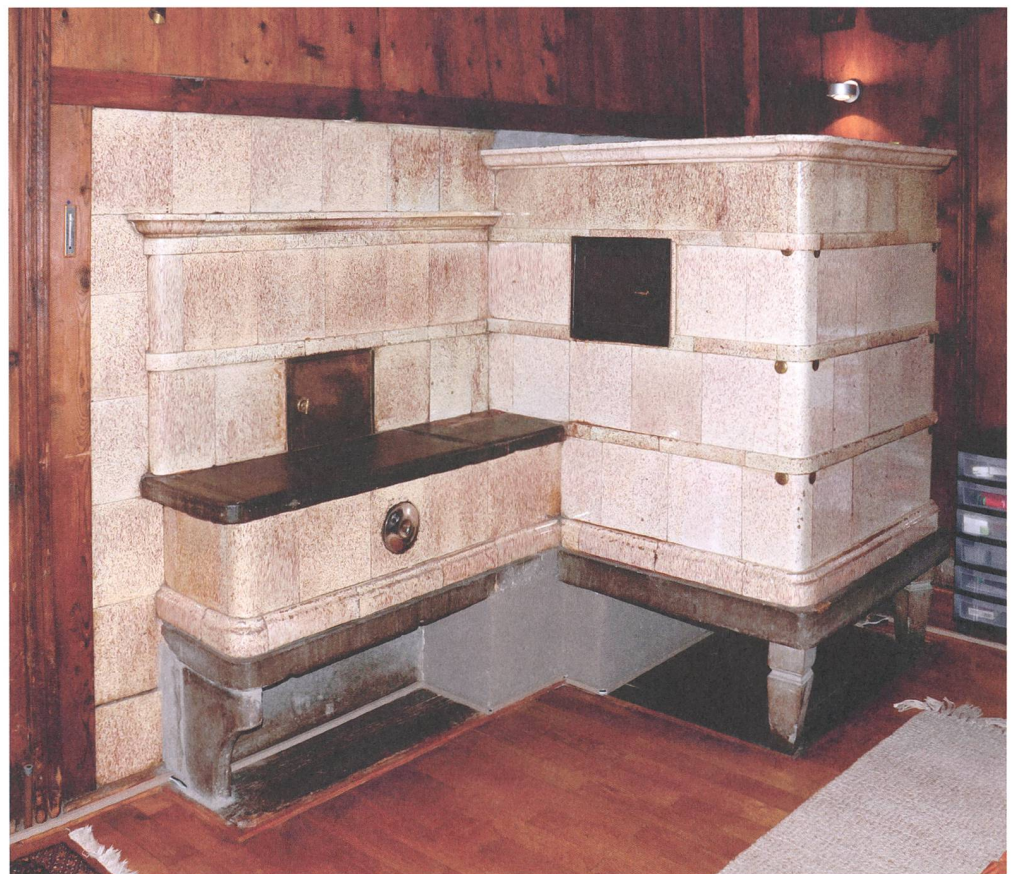
Abb. 259: Kachelöfen der Hafnerei Lötcher? Dekor mit Farbkörpern in der Grund- engobe. 1 Schiers, Schuder- serstrasse; 2 Seewis, Schloss- strasse 13; 3 Fläsch, Krüzgass 1/ «Grosshaus». Alle Öfen ohne bekanntes Erbauungsdatum.
