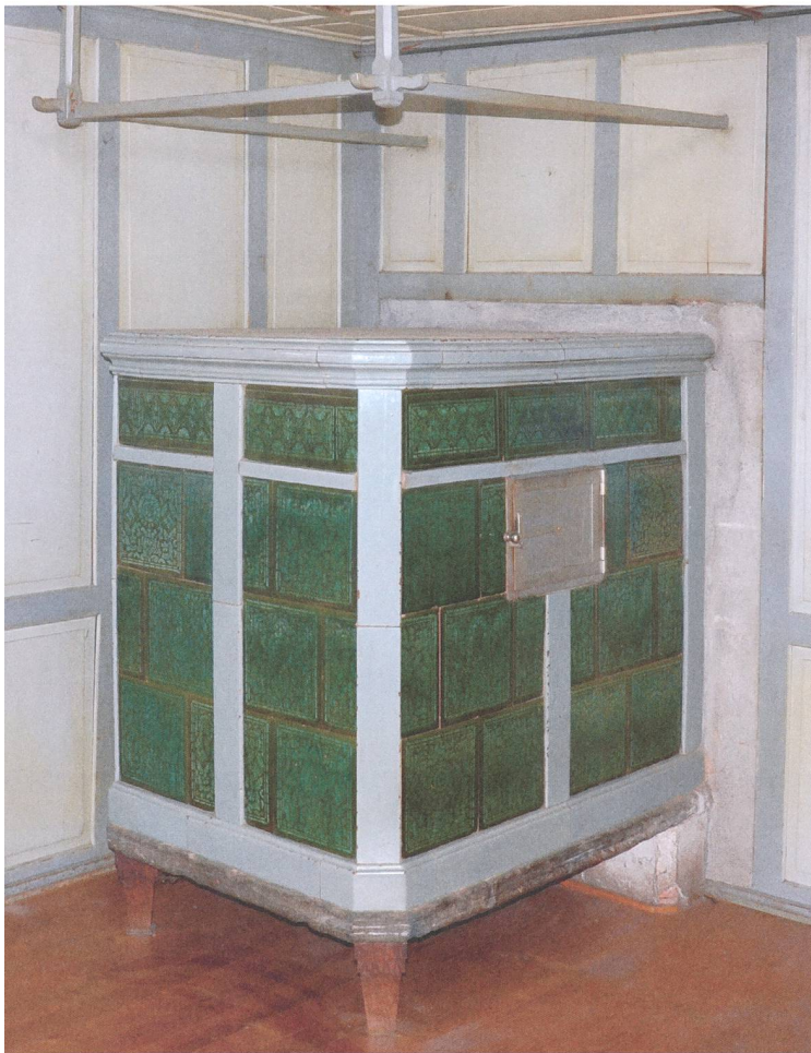
Abb. 245: Grüşch, Landstrasse 64. Heute abgebrochener Kachelofen von Christian Lötcher (1821–1880) auf steinerner Basisplatte und Holzfüssen.
