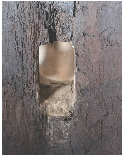
Abb. 50: St. Moritz-Bad, bronzezeitliche Quellfassung. Unverfüllte Öffnung an Röhre 1 mit deutlich sichtbaren Quetschungen. Masse: 7,3 cm × 5,6 cm. Ansicht von innen.
