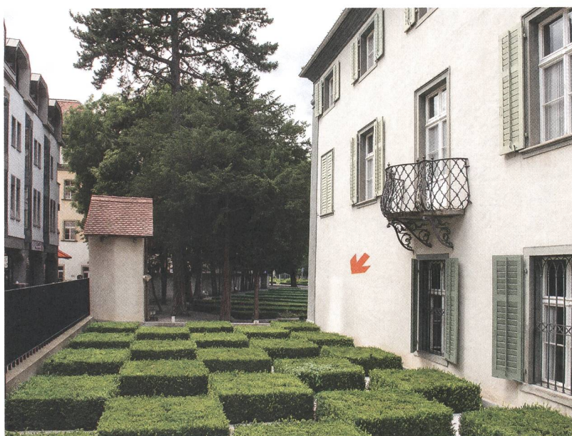
Abb. 2: Chur, Altes Gebäude, S-Fassade, Aufnahme 18.9.2012. Dunkle Flecken (Pfeil) beidseits des früheren Durchgangs zum Staubigen Hüetli .
