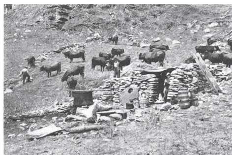
Abb. 122: Unterwallis, Gemeinde Nendaz, Alp Cleuson, 2310 m ü. M. Die Abbildung zeigt ein Alpgebäude mit viereckigen Grundmauern in Trockenmauertechnik, darüber wurde eine Stoffplane gezogen. Das Gebäude diente nur zum Wohnen, gekäst wurde vor der Hütte im Freien. Aufnahme vor 1940.
