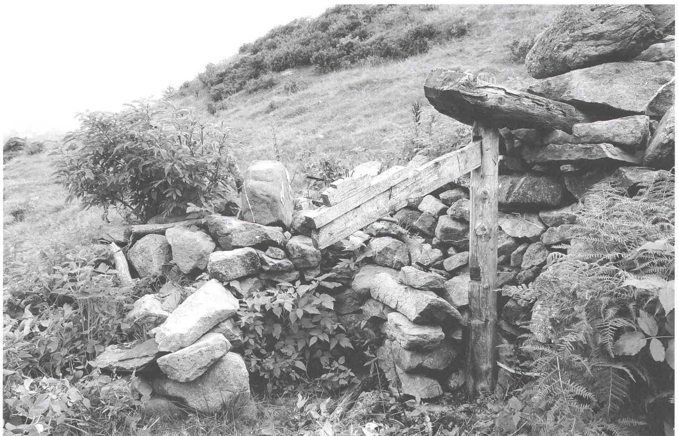
Abb. 19: Gemeinde Cusio, Val Mora, Alp Foppa, calécc . Die Feuerstelle, furnèl , mit dem Turner, màsna . Dieser dreht oben in einer Astgabelung, furscèl , und unten zugespitzt in der Ausnehmung eines Steines, sàs dela màsna . Aufnahme 25.7.2011.
