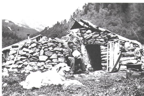
Abb. 128: Département Pyrénées-Atlantiques, Région Aquitaine, Vallée d'Ossau, Caillou de Soques, cabane de berger . Auch in dieser Region finden sich auf montaner Stufe temporär genutzte Bauten mit einem mobilen Dach. Aufnahme 1950er Jahre.
