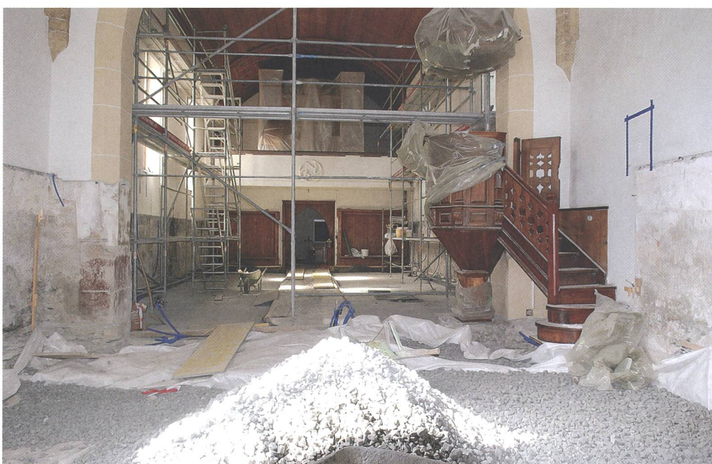
Abb. 6: Tamins, evangelisch-reformierte Kirche. Renovation 2010/11. Die Betonplatten links und rechts des Mittelgangs im Schiff sind gegossen. Im Chor wird die Dämmschicht aus Glasschaum (Misapor) aufgetragen, bevor der Betonguss folgt. Blick gegen Westen.
