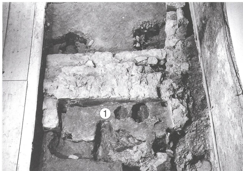
Abb. 14: Tamins, evangelisch-reformierte Kirche. Renovation 2010/11. Das als Nische ausgebildete Stiftergrab (1) an der Westseite von Kirche 3a (14. Jahrhundert). Blick gegen Osten.
