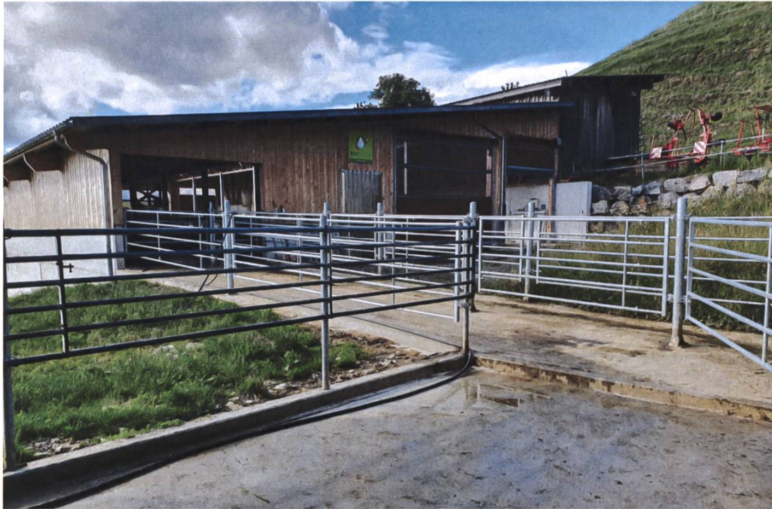
Abbildung: Im Hang eingebetteter Milchviehstall mit Pultdach im Emmental.
