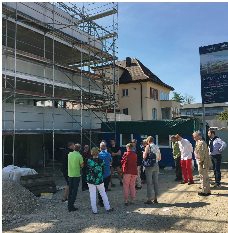
Printemps du patrimoine, visite d'un chantier, Estavayer-le-Lac, 21 avril 2018.
