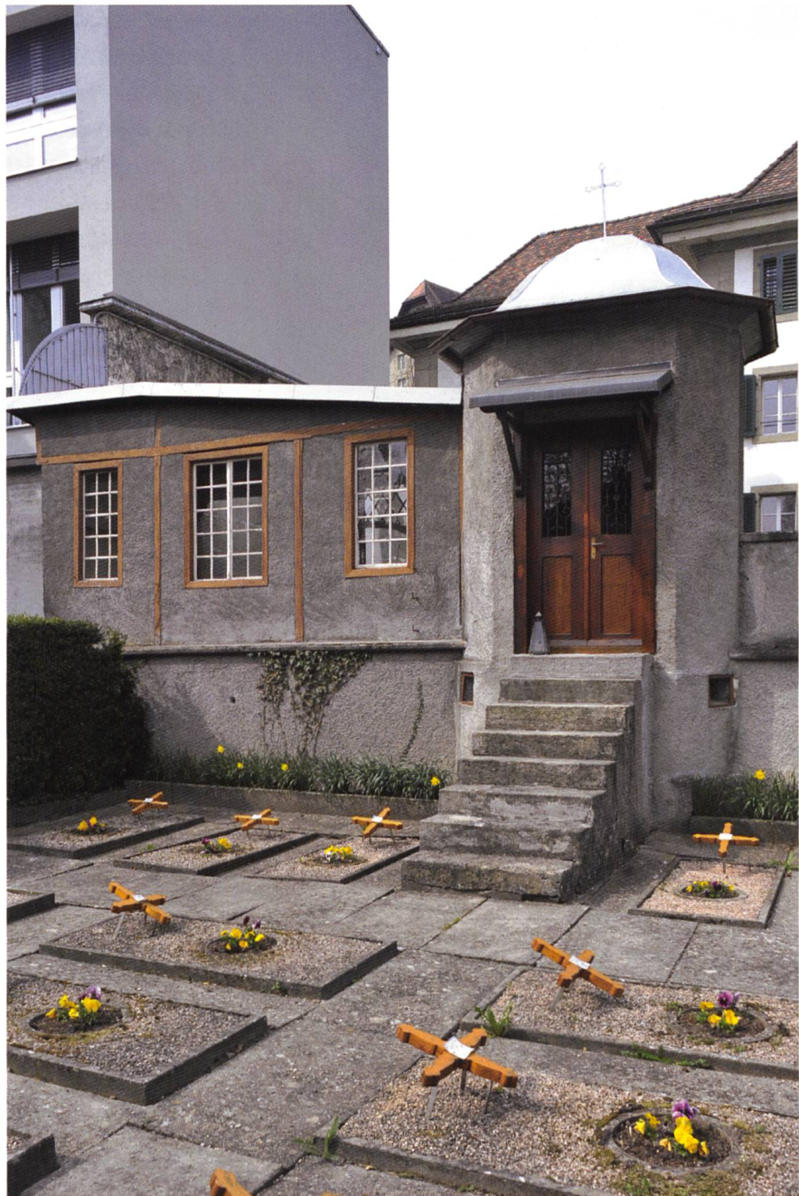
Fig. 5 Dans le jardin clos du monastère, le cimetière avec sa chapelle octogonale de 1736, état en 2010, avant le réaménagement de 2012. Abritant chacune deux défuntes, les tombes sont identiques: un rectangle gravillonné avec un médaillon accueillant des fleurs et une croix de bois trilobée sur laquelle sont inscrits les deux noms (SBC, Frédéric Arnaud).
